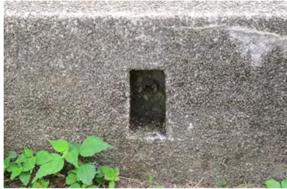
圖 4-14 位於基礎的電路管線
