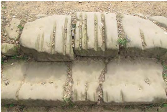
圖 4-3 鋼纜磨擦階梯所留下的痕跡
