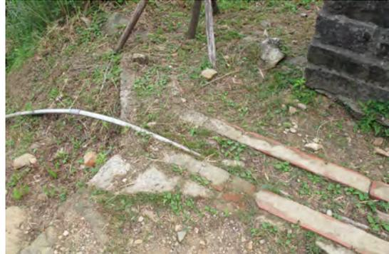
圖 4-2 T.R.磚砌成的排水溝
