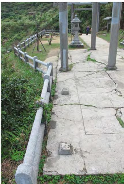
圖 4-48 拜殿圓柱上溝槽與地坪上的柱礎
