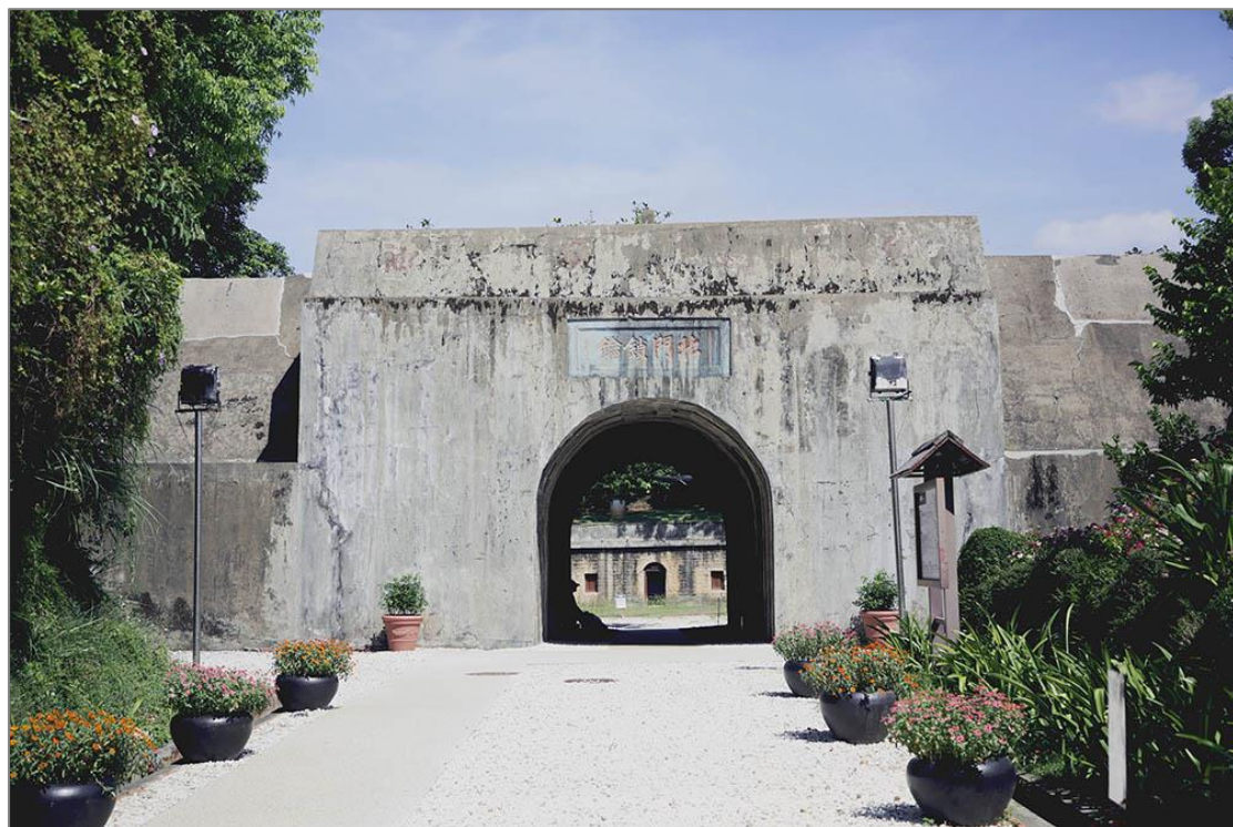
圖 1 國定古蹟「滬尾礮臺」入口處（營門）
