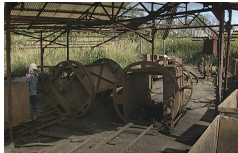
— 卸煤斗翻車台 —
