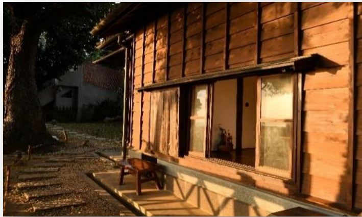
多田榮吉故居建築雨淋板
