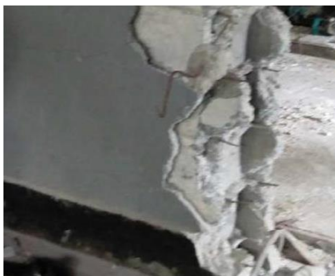
圖 1-6 建物內中空混凝土牆面
