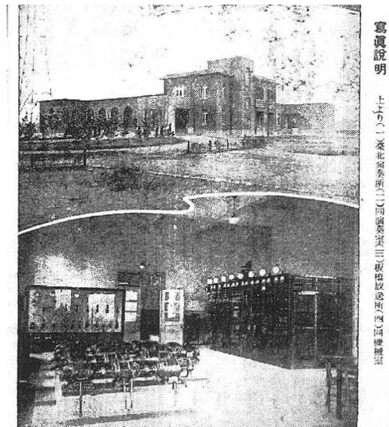
圖 1-2 板橋放送所及其機械室
