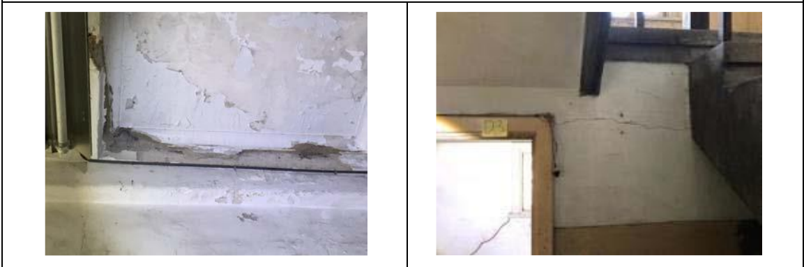
樓板混凝土剝落
