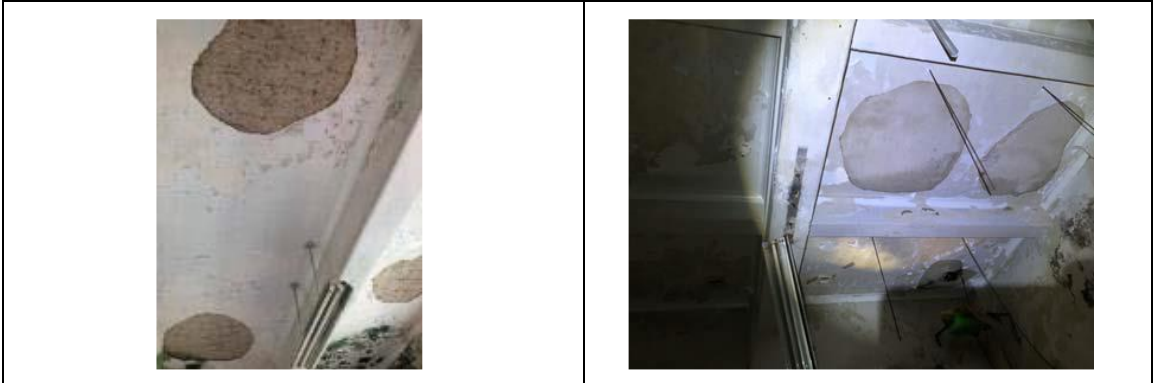
樓板混凝土剝落
