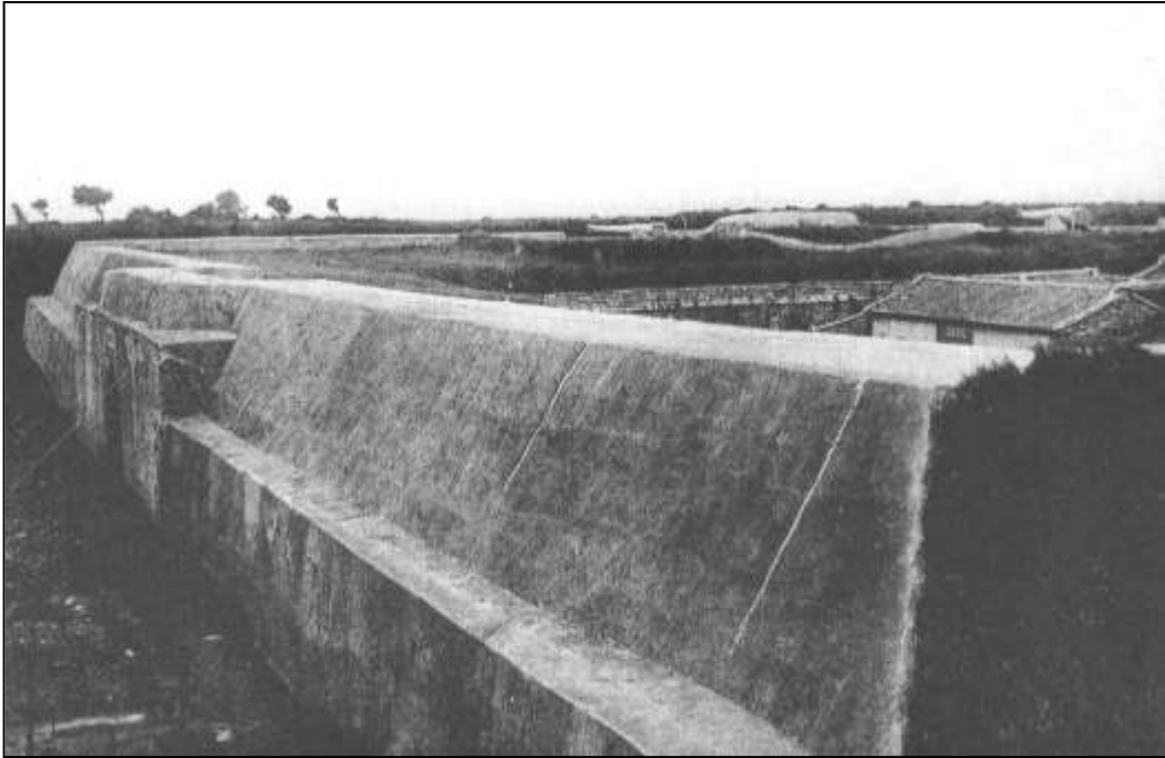
圖 12 從日治時期所留存的照片可看到遠處砲臺的配砲
