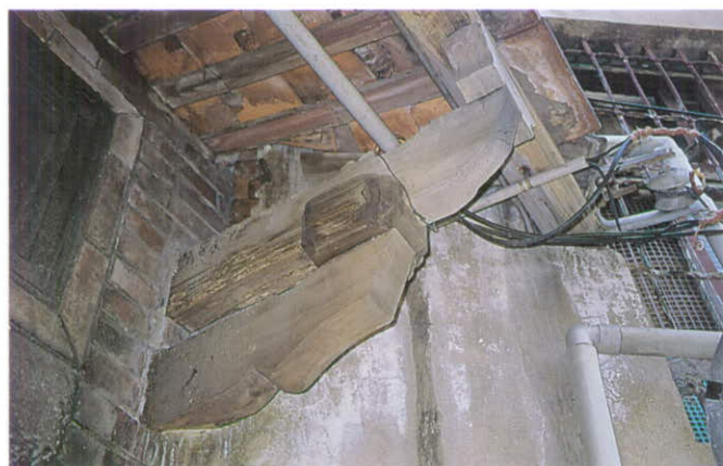
門樓斗拱出二跳，並施捧前砧。
