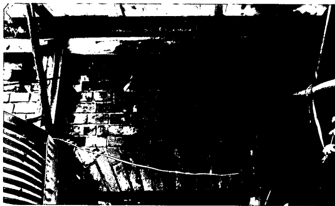
護龍門楣使用磚砌平拱（flat arch）（註48）作法。
