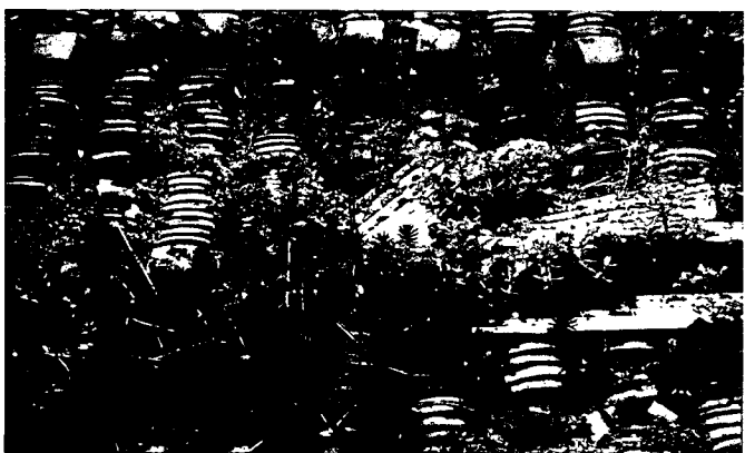
屋頂磚瓦易位，雜草叢生。
