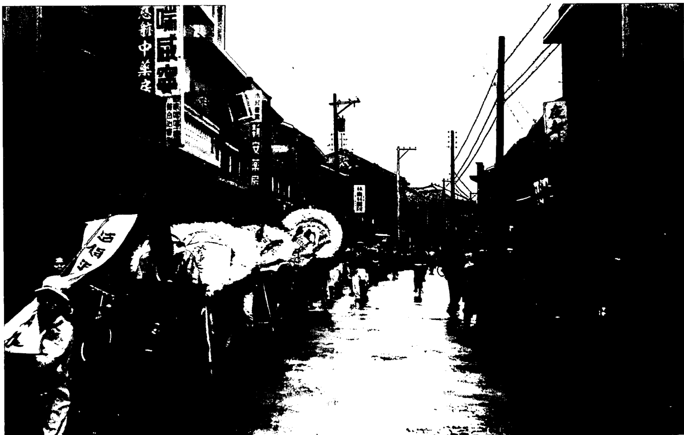
照片18-6：中正路未拓寬前週邊街景的老照片。（蘇文魁提供）
