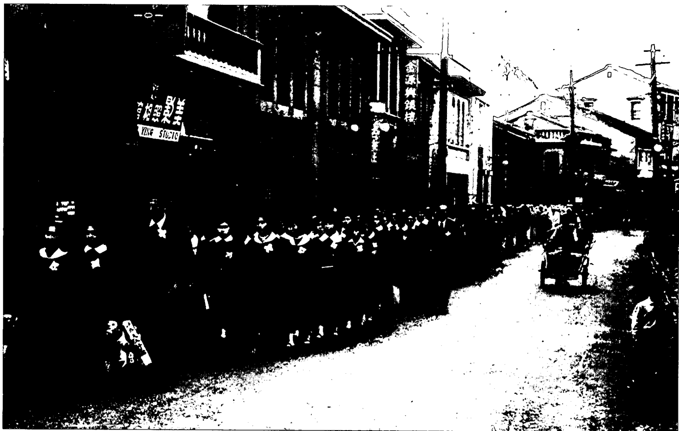
照片18-5：中正路未拓寬前週邊街景的老照片。（蘇文魁提供）
