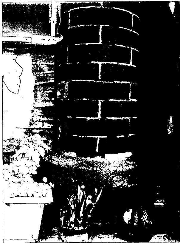
清理磚柱、柱礎與周圍雜物，保留紅磚圓柱與柱礎。灰縫補作時，應注意保存原有灰縫「指甲圓」作法。
