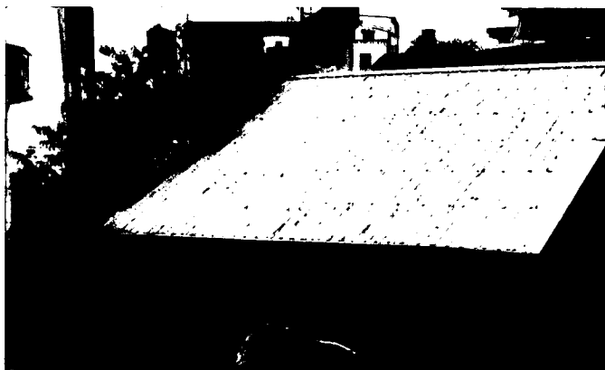
正身虎邊架設大鋼棚以避免屋頂漏水。
