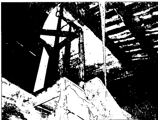
保留閣樓、階梯與欄杆，拆除前、左、右與上方加建木板隔間還原木棟架舊貌。
