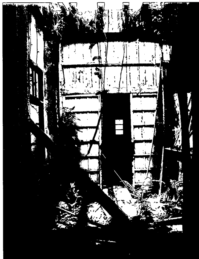
室內潮濕積水與掉落的桁木等構件。
