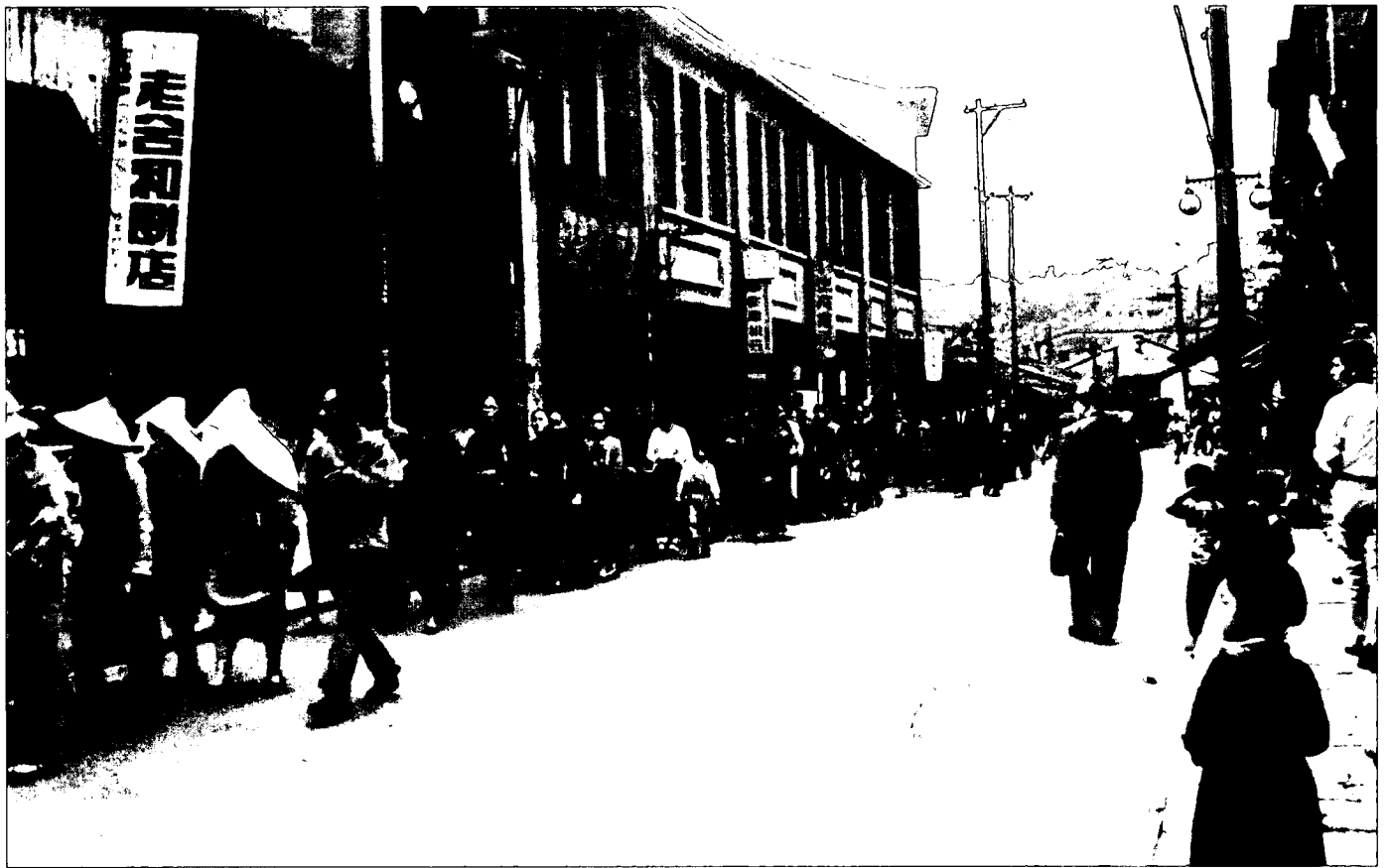
照片 18-3：中正路未拓寬前週邊街景的老照片。（蘇文魁提供）
